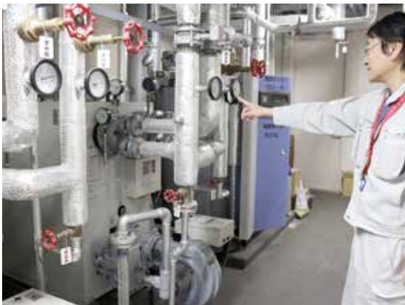
用度施設管理課（ボイラー室）
